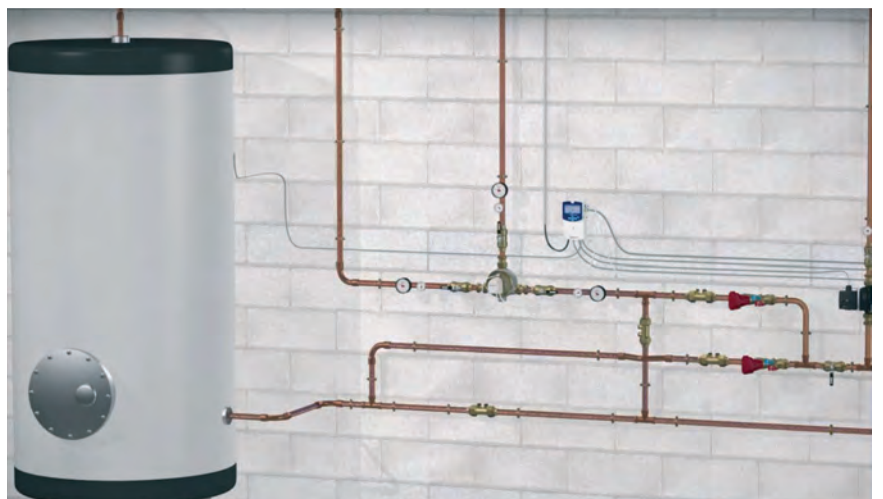
Zastosowanie zaworu mieszającego w kotłowni domku jednorodzinny na wyjściu z zasobnika
